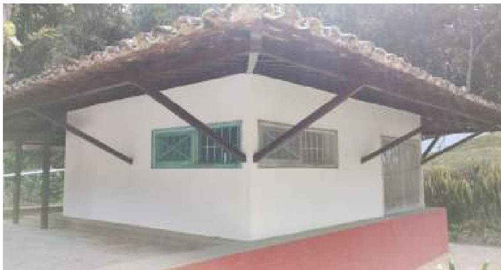
Casa de Proteção
