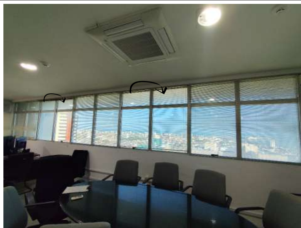
Foto 22: Sala de Reuniões da Direção Geral (substituição)
