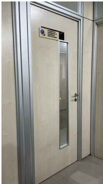
FOTO 03 - Porta existente a ser relocada (Foto 01) e permutada por painel fixo.
