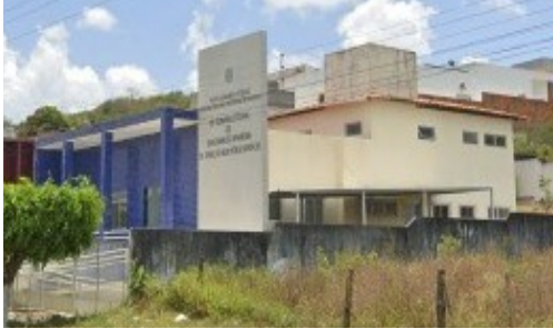
Foto 6: Fachada lateral direita
