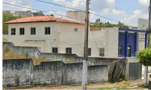
Foto 7: Fachada lateral esquerda
