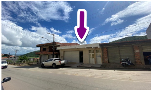
Imagem real da fachada
