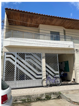
Imagem real da fachada
