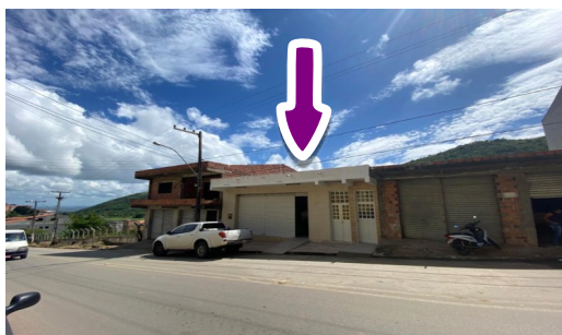
Imagem real da fachada
