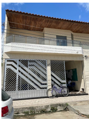
Imagem real da fachada
