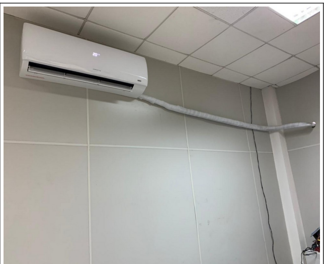
Foto 4: Vista da parede com o ar split
