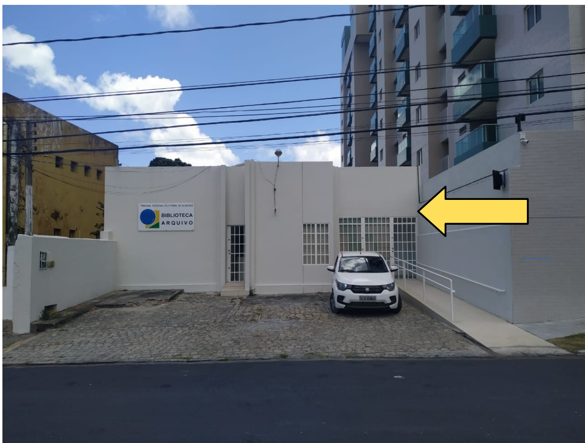
Fig. 1: Locação do toldo na fachada
