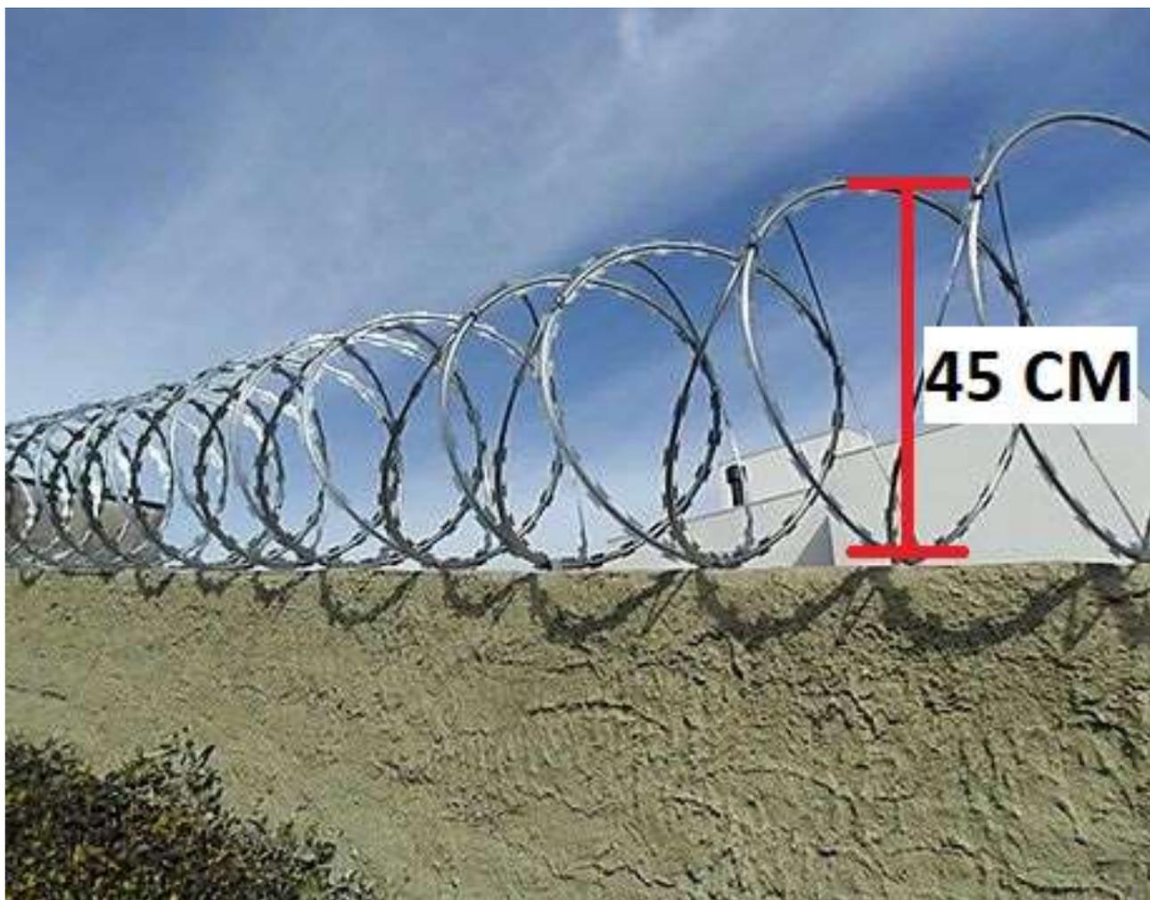
Foto 01: Imagem meramente ilustrativa para indicar a altura/diâmetro das concertinas duplas requisitadas.
