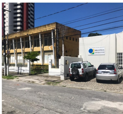
FOTO 02 -Vista vizinho lateral esquerdo
