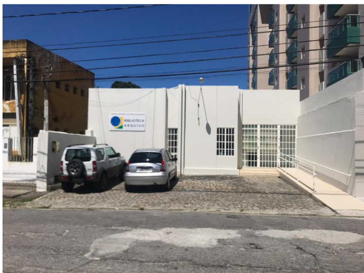
FOTO 01 – Vista fachada principal
