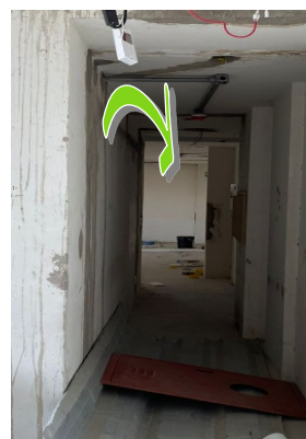
FOTO 6: de acesso ao Coffee Break pela Circulação (P6)
