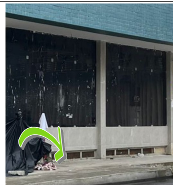
FOTO 14: gradil de vista para o Subsolo (ver detalhe J3).
