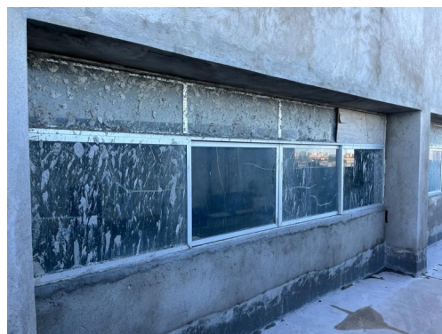
FOTO 12: vista do Terraço (J1)
