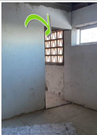
FOTO 1: Acesso a Laje Técnica (P1)
