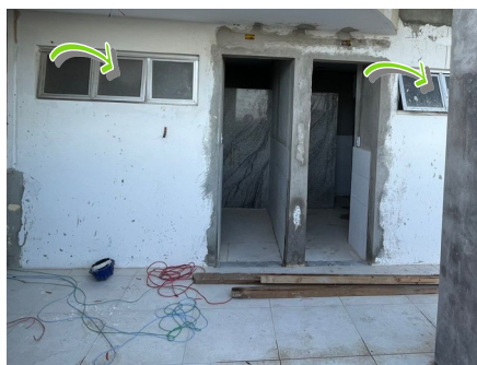
FOTO 13: Janelas externas dos Lavabos (J2)
