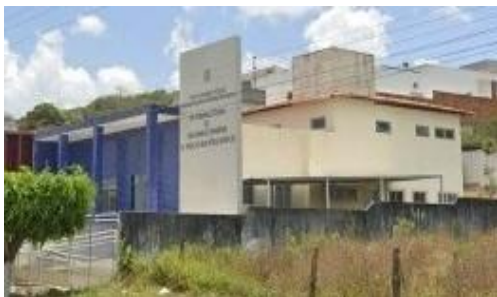
Foto 6: Fachada lateral direita
