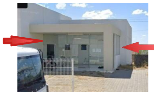
Foto 5: Esquadrias de vidro da 31ª ZE em Major Izidoro
