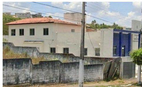
Foto 7: Fachada lateral esquerda
