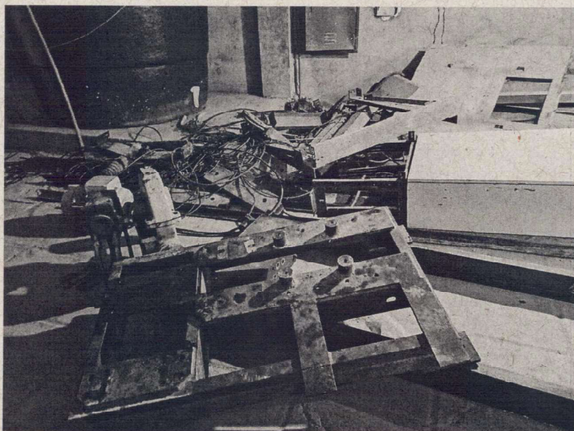
Foto 04: PEÇAS METÁLICAS DO ELEVADOR DESMONTADO
