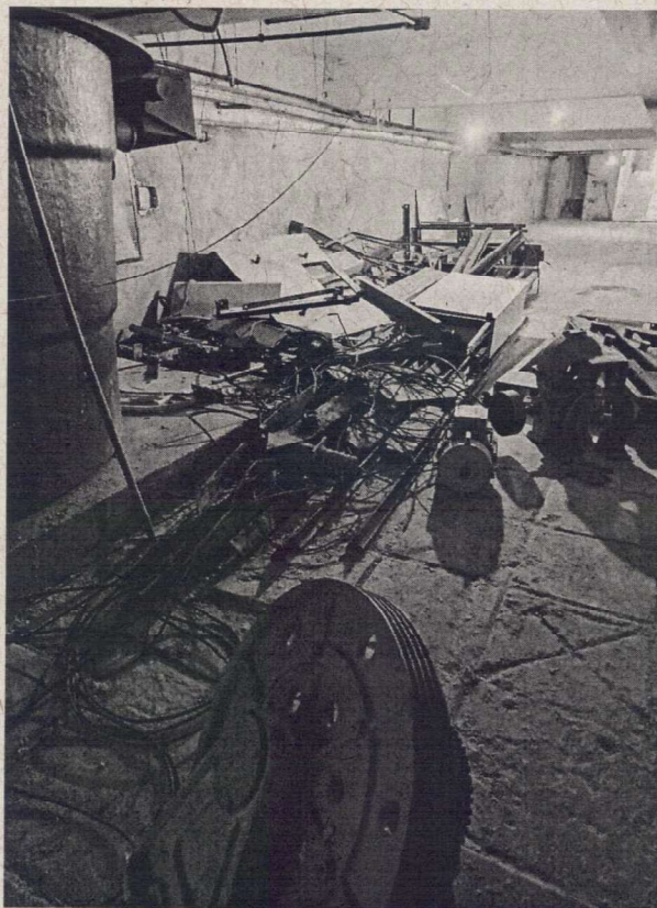
PEÇAS METÁLICAS DO ELEVADOR DESMONTADO
